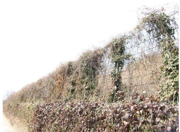
낙석방지울타리 및 하부 전경
