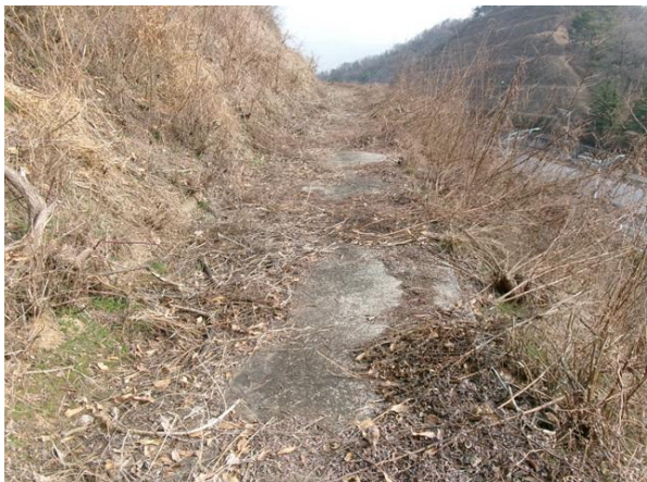
1소단 배수로 전경
